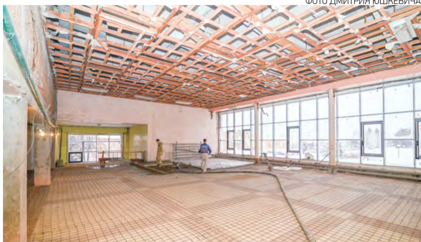
Сегодня в танцевальном зале на втором этаже завершается стяжка полов (фото сверху). По окончании реконструкции зал примет современный вид (фото внизу).
