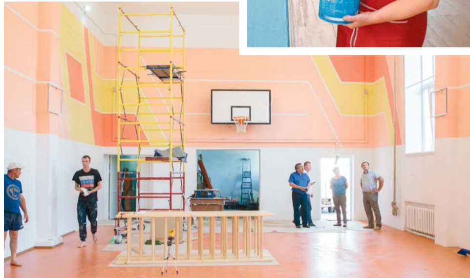
На снимке сверху: гардеробщица Заливинской школы Марина Януш занята покраской коридора. На снимке внизу: ремонтные работы спортивного зала в Междуреченской школе подходят к завершению.
