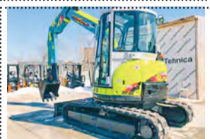
Экскаватор. Закручиваем сваи. Услуги гидробура. Т. 8-929-363-0211.
