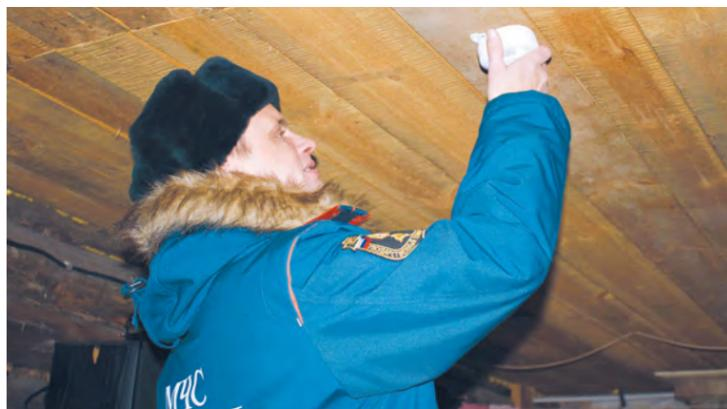
ные извещатели улавливают наличие в воздухе продуктов горения и при повышении их концентрации подают тревожный звуковой сигнал, да еще так громко, что способны мертвого поднять.
