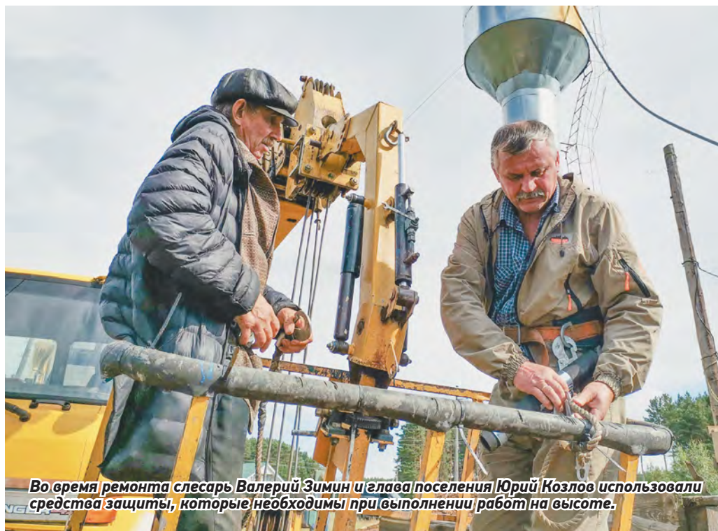
Порыв, случившийся на водонапорной башне, пришлось устранять, стоя на подъемнике.
