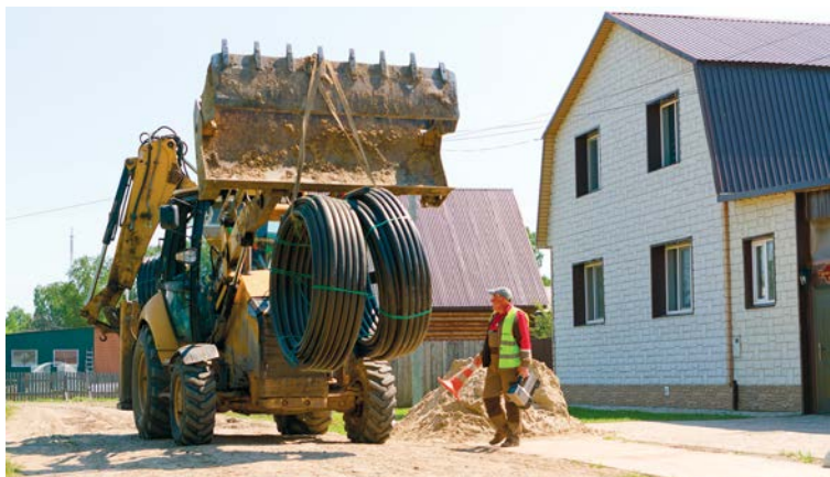
Идет прокладка газораспределительных сетей в микрорайоне Опытном.
